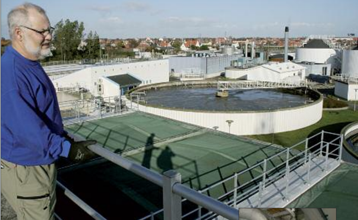
Leo Svendsen med et flot vue ud over det komplicerede rensningsanlæg.
